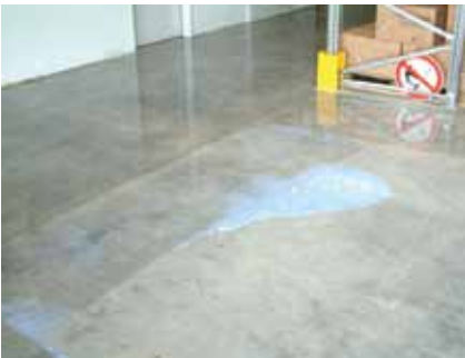
Industrieboden vor der Grundierung
