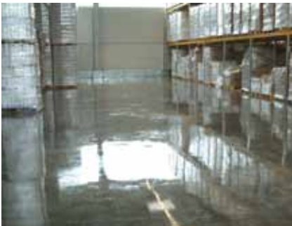
Industrieboden direkt nach der Beschichtung
