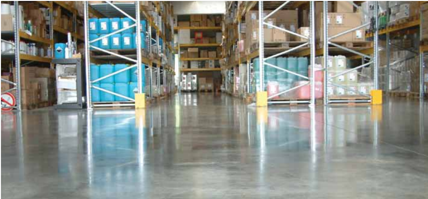
Industrieboden nach der Beschichtung
