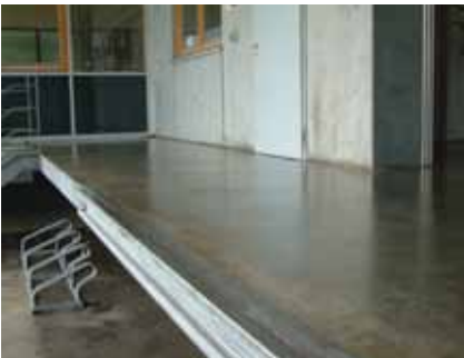
Industrieboden im Außenbereich nach der Beschichtung
