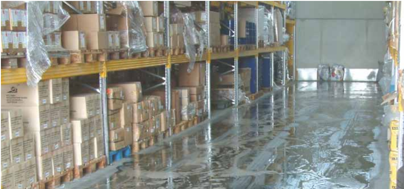
Industrieboden während der Grundreinigung (Reinigungsflotte wirkt ein)
