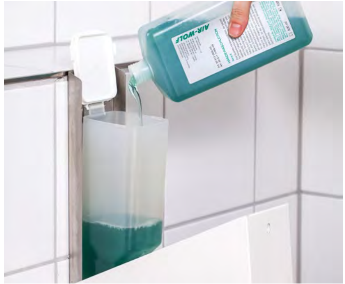
Richtig montiert befindet sich der Spender oberhalb des Waschbeckens und ist zur Befüllung frei zugänglich.
